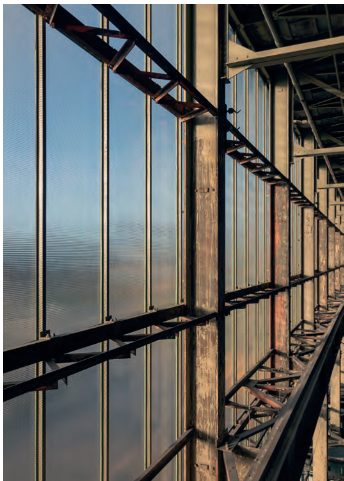
De bestaande stalen kozijnprofielen zijn schoongemaakt en voorzien van enkel bruut draadglas voor een diffuse lichtfiltering.
