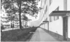
Bauteil Bartning Nordseite
