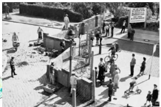
bouw van de muur
